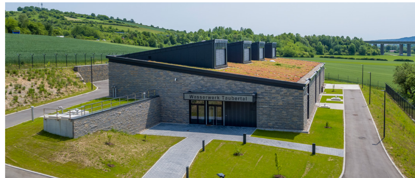
Bild 2: Für die Außenwände des Wasserwerks wurde Naturstein verwendet, der vor Ort existiert.
