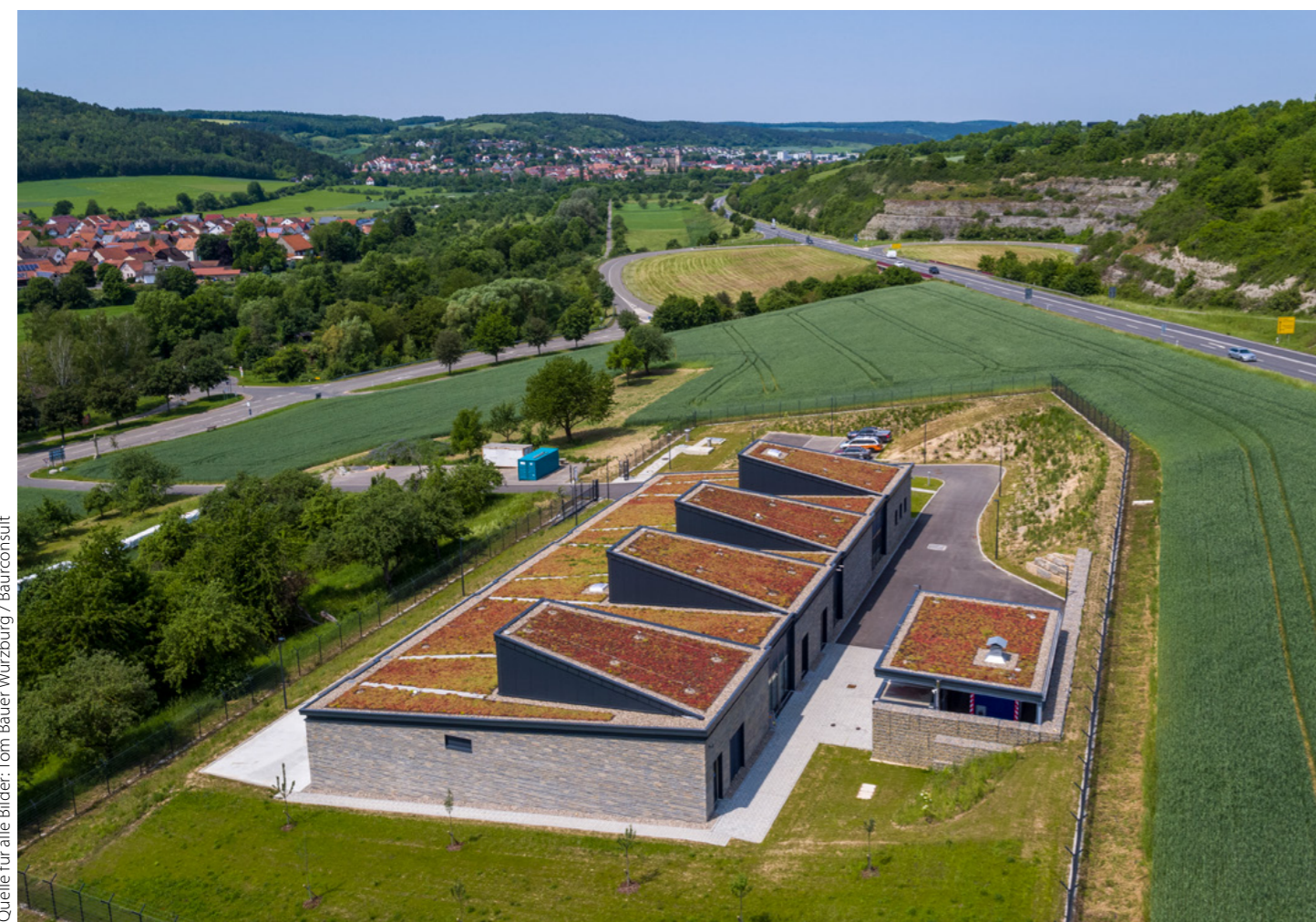
Bild 1: Das Wasserwerk Taubertal versorgt rund 40.000 Einwohner mit 2,3 Mio. m 3 Trinkwasser pro Jahr.
