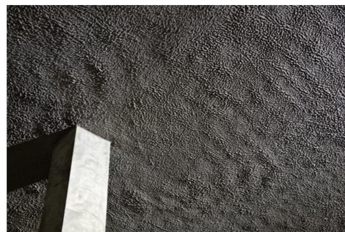
Bild 2: Um die für Trinkwasserbehälter geforderte Tropfenstruktur-Oberfläche der Decke zu erreichen, wurden der Nassspritzmörtel Sika-130 HD und im zweiten Arbeitsgang der zementgebundene Dichtungsmörtel Sika-110 HD aufgebracht.
