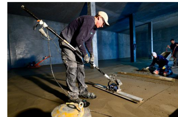
Bild 4: Abschnittsweise wurde die letzte Schicht des Trockenspritzmörtels aufgebracht...
