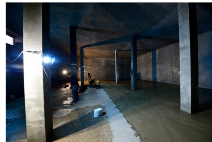
Bild 3: Auf den bis zur Sättigung gewässerten Betonboden wurde der zementgebundene feinkörnige Dichtungsmörtel Sika-110 HD als Haftbrücke aufgebracht.
