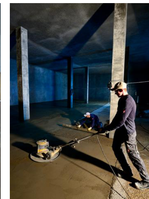
Bild 6: ...und mit einem Flügelglätter glattgezogen.
