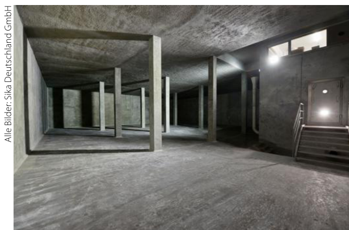
Bild 1: Blick in eine der beiden Wasserkammern vor der Befüllung mit Trinkwasser, die zusammen ein Fassungsvermögen von 2.800 m 3 haben.
