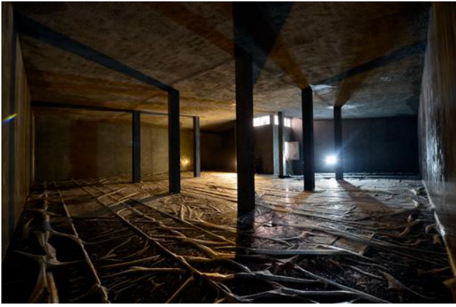
Bild 7: Bis zur Befüllung der Wasserkammern wurden die beschichteten Böden feucht gehalten.
